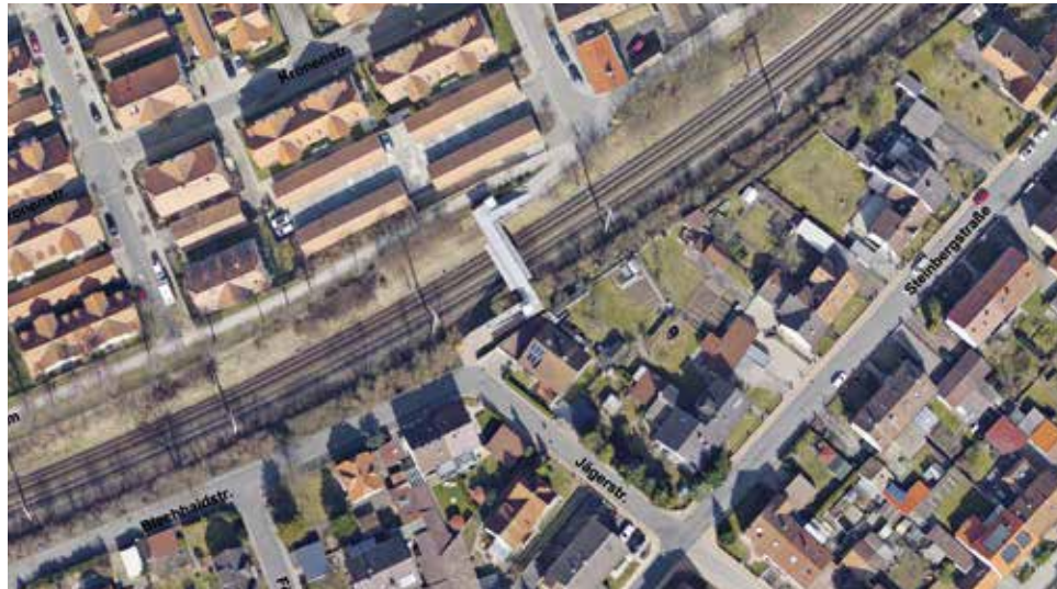
Luftbild Fußgängersteg Grabenstraße/Blech- haidstraße, 2016
